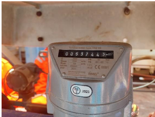
Gambar 6.6. Gas Metering Lokal GT
