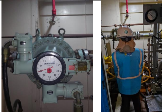
Gambar 6.3. (kiri) flow meter HSD, (kanan) verifikasi area fuel metering oleh tim verifikator
