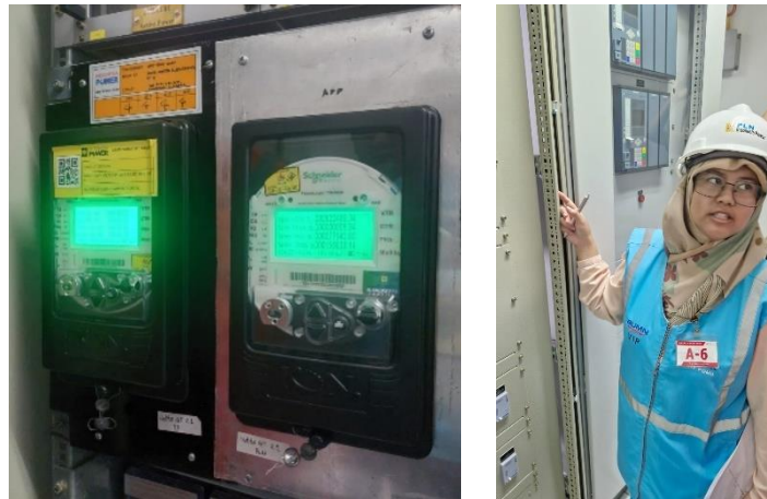
Gambar 6.4. (kiri) kWH meter utama kirim dan kWH pembanding, (kanan) verifikasi control panel oleh tim verifikator
