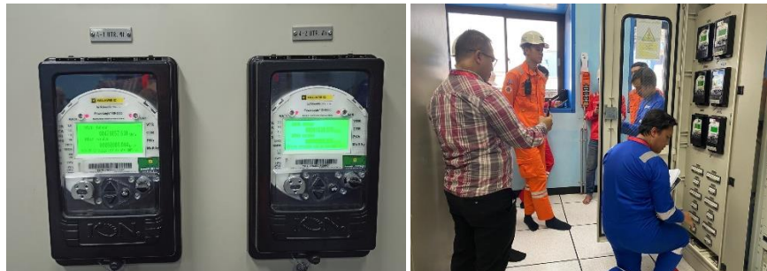
Gambar 6.3. (kiri) kWh meter utama kirim dan kWh pembanding (kanan) verifikasi control panel oleh tim verifikasi
